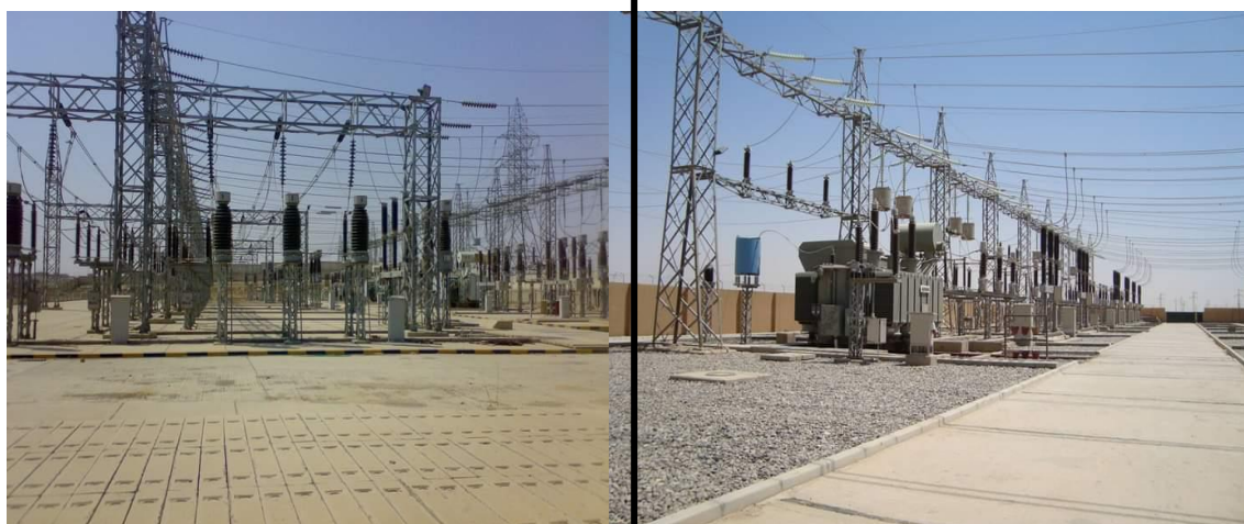
صورة (١ ١) تبين محطات تحويلية ثابتة ومتنقلة ذات جهد K.V(١٣٢/٣٣)
